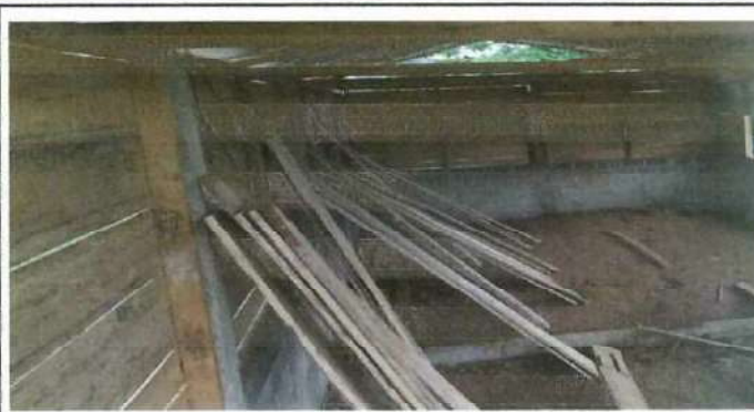
Foto 2: Colocacion estructura de Metal
