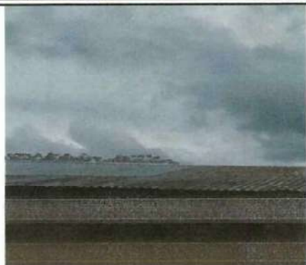
Foto 1: Cambio de techo.
