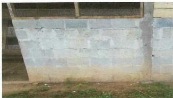
Foto 3: culminacion de muro
