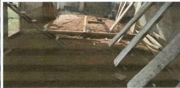
Foto 4 : Fundicion piso de concreto
