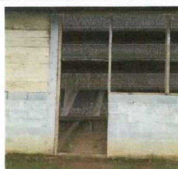
Foto 6: Colocar puertas de metal.
